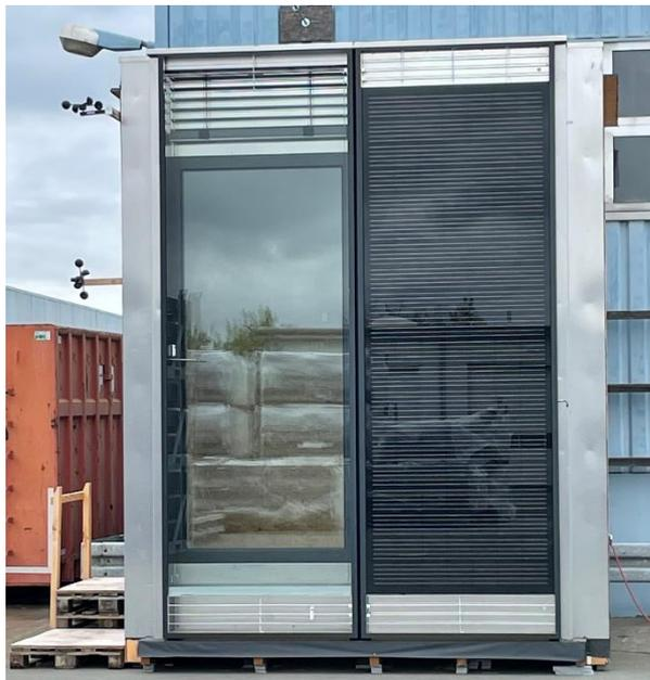
Bild 3 – PRÄKLIMA-Fassadensystem.
